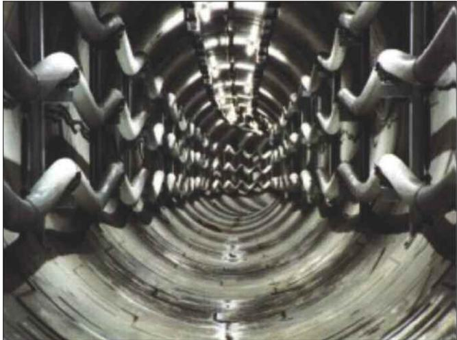
Figura 5 Cavi AAT installati in un tunnel profondo 20 m sotto Berlino.
