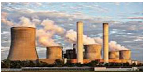
Impianti di generazione
