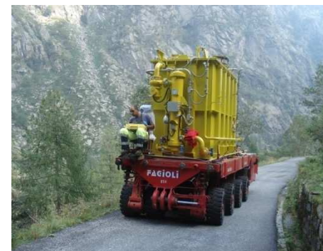
Trasformatore da 15 MVA raffreddamento OFWF
