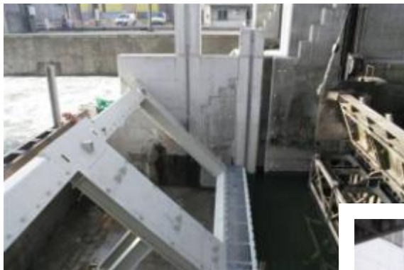
Installazione della VLH nella struttura di supporto
