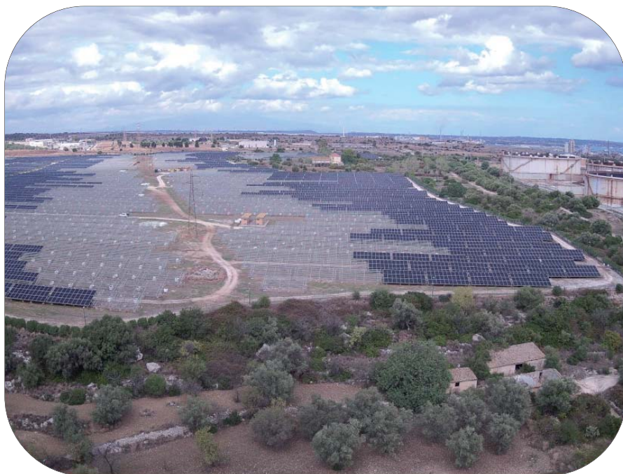
Figura 7 Impianto di Priolo
