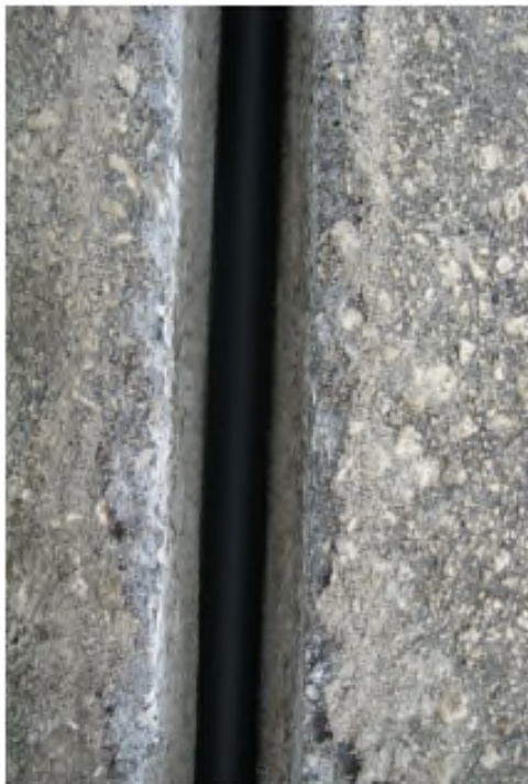
Scavo aperto con tubazione posata
