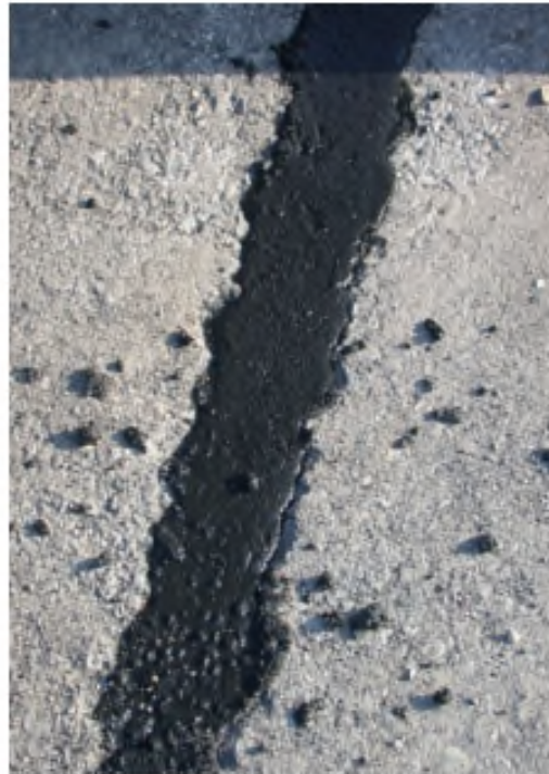
Materiale subito dopo il riempimento
